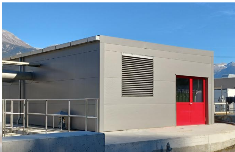
Grille acoustique 1600 x 1600 mm, STEP de Chandolin
